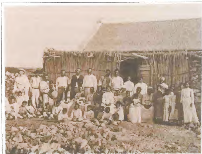
Foto 3.2. Uit: Aruba in oude ansichten, door: J. Hartog Op deze oude foto zien we een kurpa di kas welke met een torto dak bedekt is. Daarvoor is een ramada van palmladeren gebouwd.
